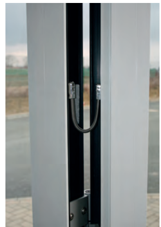
Abb. 32: Kabelführung Rahmen – Flügel
