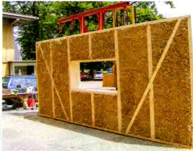
Das Wandelement aus Stroh und Holz wird mit einem Kalkputz abgedichtet.
