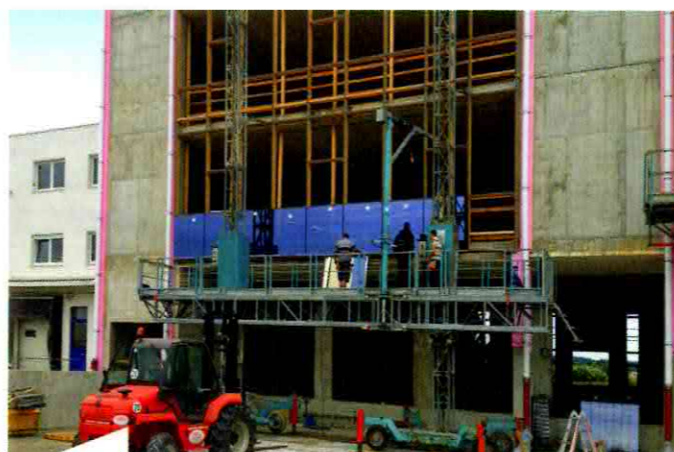
Bild von der Baustelle des Logistikzentrums. Als Klebstoff für Glas und Holz wurde Ottocoll S 660 verwendet und für die Wetterversiegelungsfuge Ottoseal S 7.
