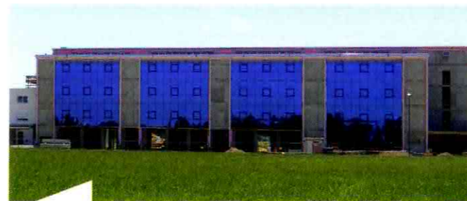
Das neue Logistikzentrum von Otto-Chemie ist mit dem neuen SSG-Fassadensystem ausgerüstet. Die Gebäudehöhe beträgt 22 m.
